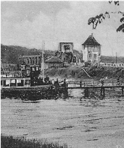
Foto: Alter Steg an der Lindaunis Brücke
