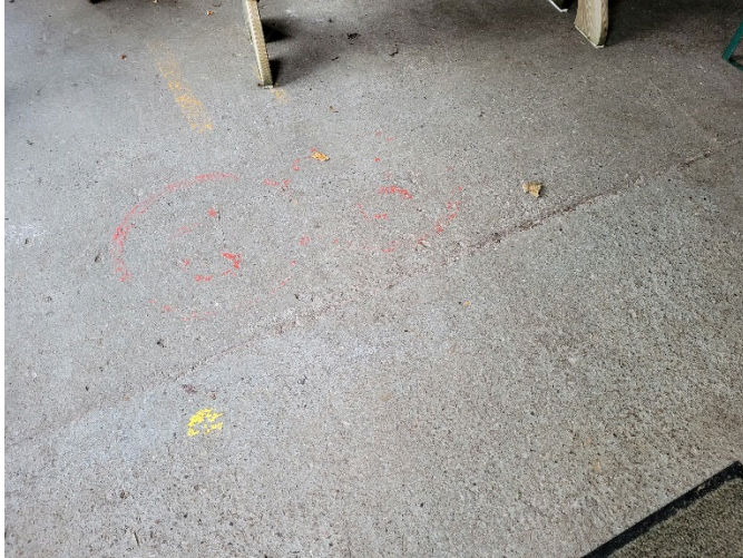
Betonboden in der Küstenwerkstatt
